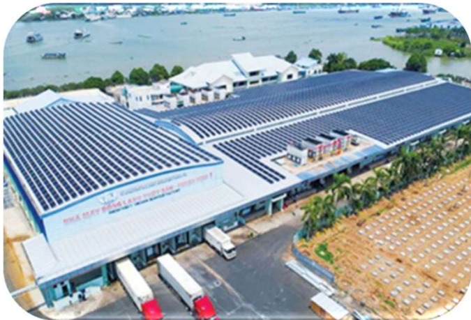
Hệ thống Pin năng lượng mặt trời áp mái nhà xưởng
