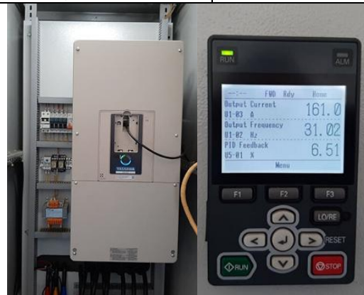
Biến tần GA700 lắp đặt cho máy nén khí
